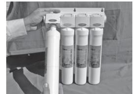
Paso D – Repita este procedimiento para el segundo y tercer cartucho de filtro. Cuando termine, enjuague el tanque completamente una vez para eliminar los finos de carbono natural del sistema de agua potable UF. Verifique durante las próximas 24 horas para asegurarse de que no haya fugas.
