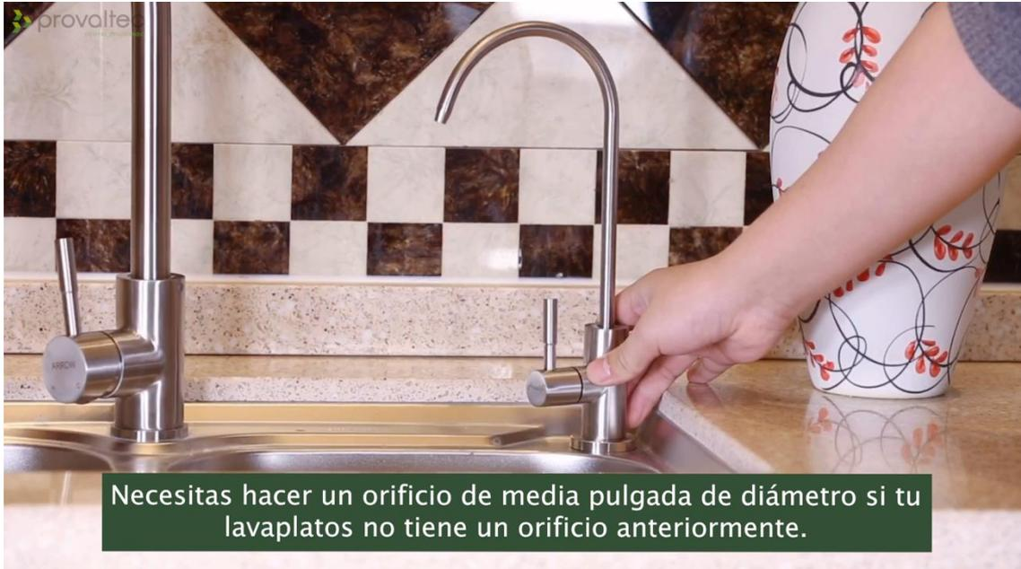
Monta el grifo en el orificio. Instala todos las gomas y aprieta bien el grifo. Conecta el tubo con el empalme entregado de tipo I, y conecta el empalme al grifo. Aseguralo con los clips azules.
