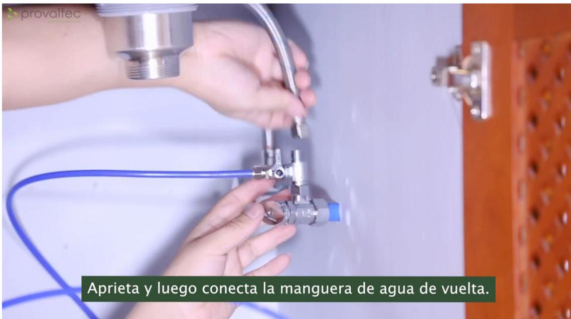
Ahora conectamos el tubo al sistema de filtro. Mide un largo adecuado y luego corta el tubo utilizando la cuchilla provista. Asegúrate de cortar el tubo de manera vertical, de forma ovalada, o la forma de la punta causara gotera.
