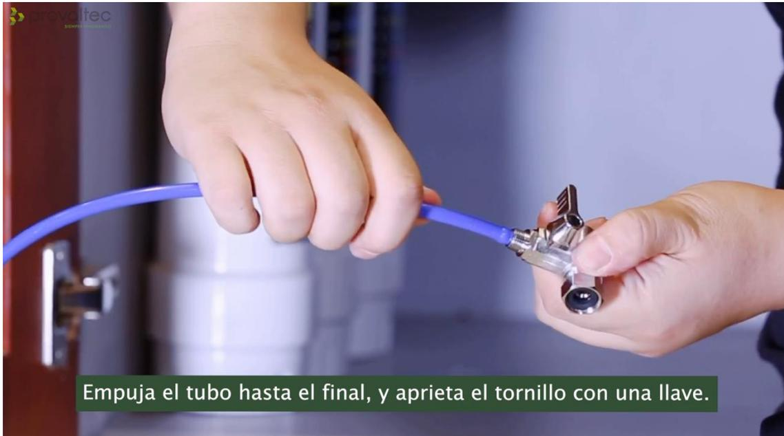
Cierra el suministro de agua, remueve la manguera existente de agua, y conecta la válvula, asegúrate que el anillo de goma esté adentro. Aprieta y luego conecta la manguera de agua de vuelta.
